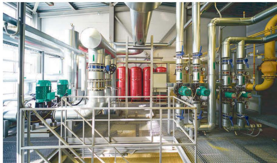
бителей. На месте подземных емкостей хранения мазутного топлива была возведена энергоэффективная газовая блок-модульная котельная мощностью 51,72 Гкал/час. Новое здание получило водогрейные жаротрубные автоматизированные котлы со сроком службы не менее 20 лет, дымовую трубу и газоходы. При необходимости к энергоисточнику можно будет добавить дополнительные блок-модули и увеличить мощность. В старом здании, где были мазутные котлы, специалисты установили насосы и современное энерго-
