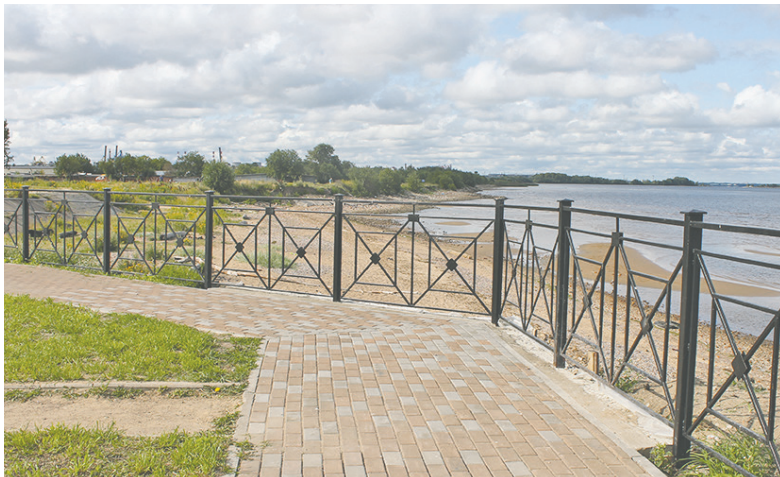
Восстановленный участок набережной Финского залива.
