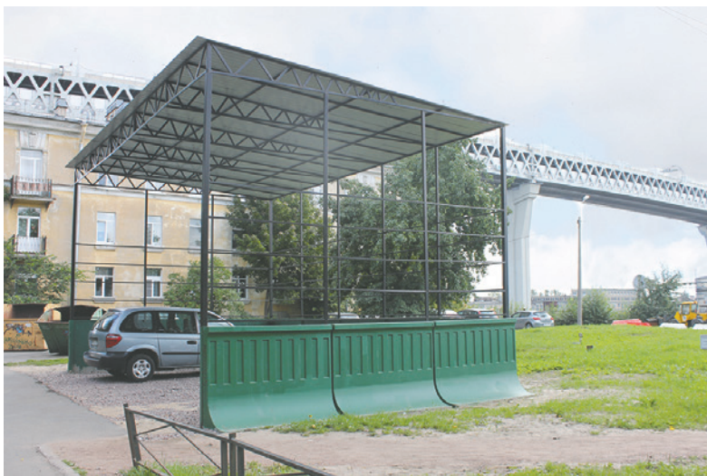
Новая контейнерная площадка на Канонерском острове, д. 12.
