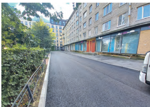
Обновлено покрытие проезда на Двинской ул., д. 8
